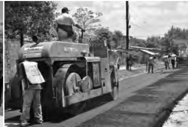
Cooperativa de Argentina Trabajando asfaltando. En el marco del plan de 1.500 cuadras previsto para este año, se terminaron 380 cuadras de hormigón y 465 de carpeta asfáltica.
